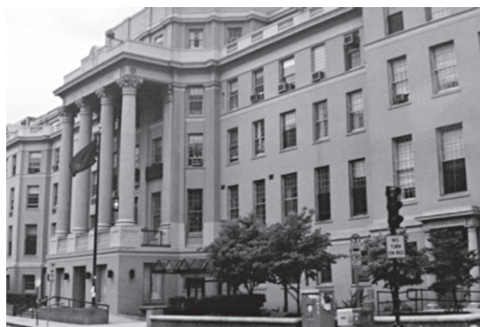
Fig.1 Longwood Ave.のボストン小児病院旧館 最初の放射線科が設立されたのは、この建物ではなくダウンタウンにあった。
